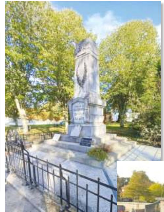
Monument aux Morts : Reprise de l'embase en béton désactivé
